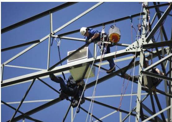
Montage eines Brutkastens
