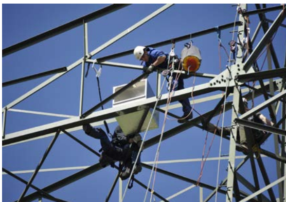
Abbildung 2.5: Montage eines Brutkastens
