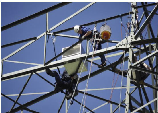
Abbildung 2-5: Montage eines Brutkastens
